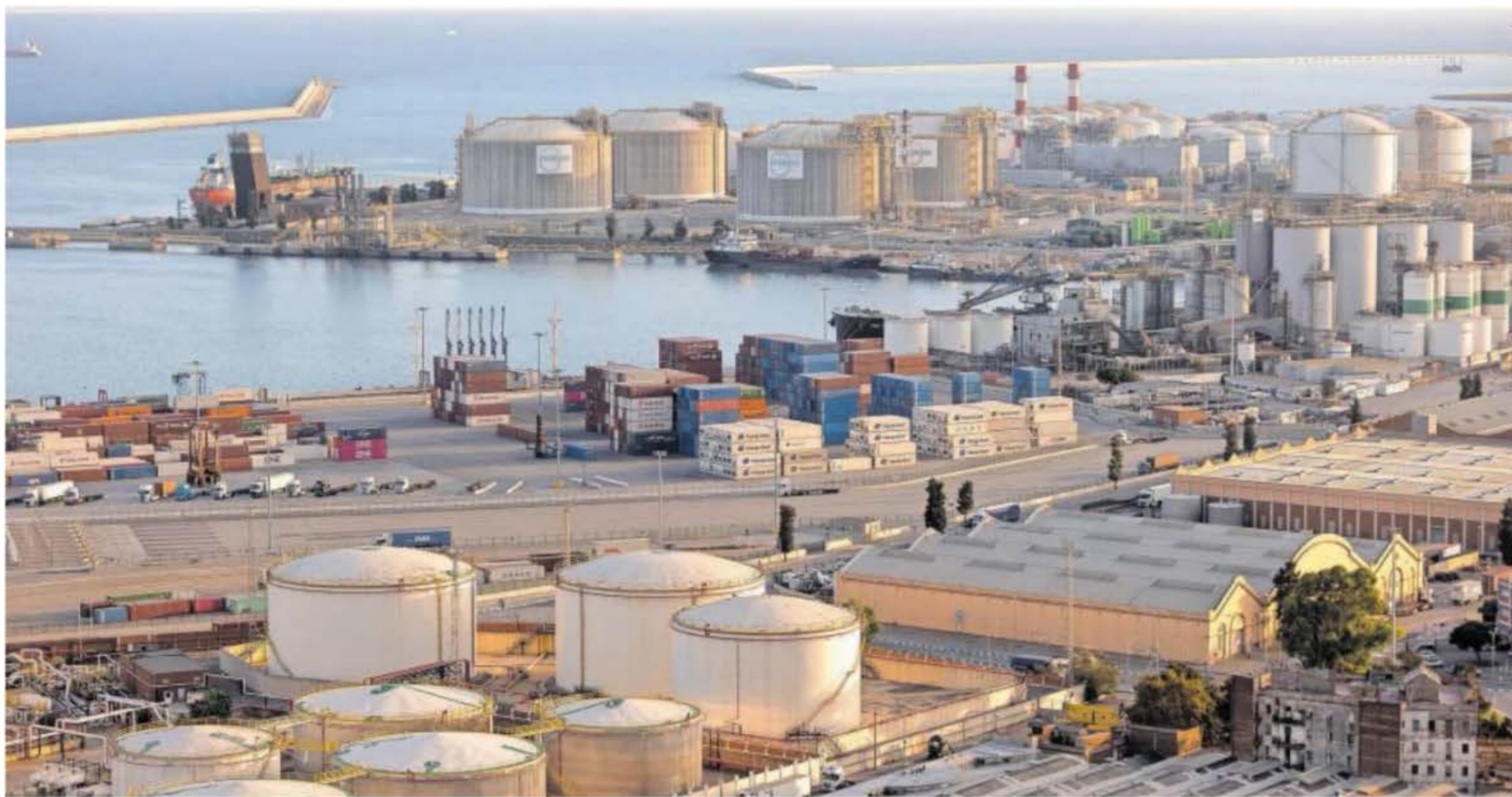
Tanques de almacenamiento de hidrocarburos de Exolum frente a una regasificadora de Enagás en el puerto de Barcelona. ALBERT GARCIA
